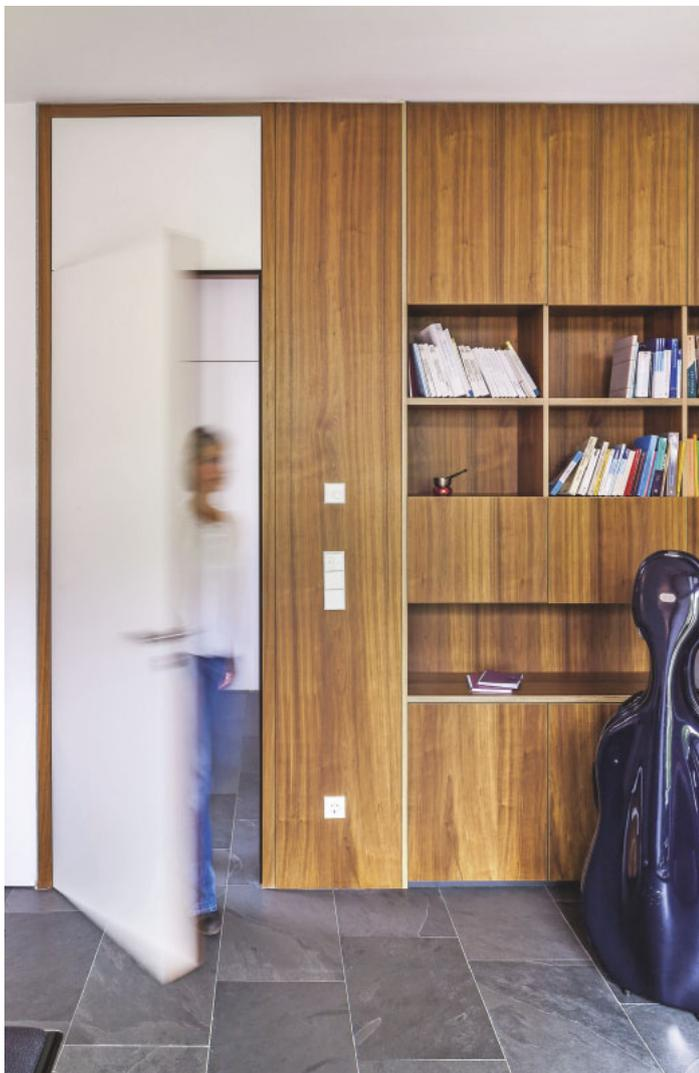
*/ Exakte Linienführung: Alle Zimmertüren, wie hier im Praxisraum, sind stumpf einliegend angeschlagen und setzen sich flächenbündig in den Möbeleinbauten fort.*
