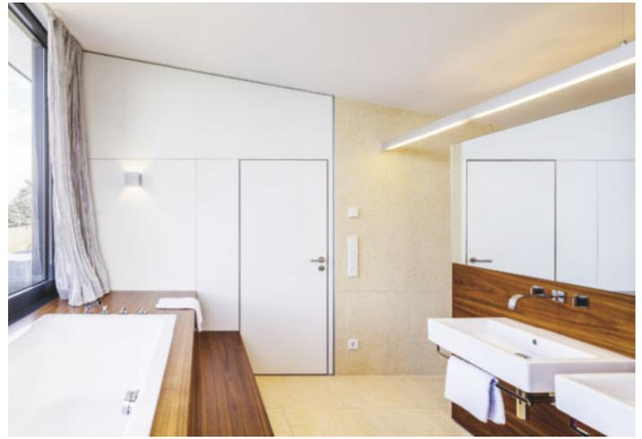
*/ Die schichtstoffbelegte Trennwand zum Elternbad im Obergeschoss ist passgenau eingefügt und mittels feiner Schattenfugen sauber vom Bauwerk getrennt.*
