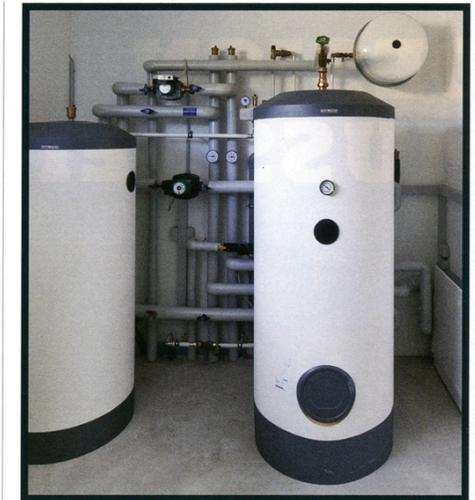
**IM TECHNIKRAUM** sind ein Pufferspeicher und ein 300-Liter-Warmwasser-Standspeicher installiert. Alle Rohrleitungen sind perfekt isoliert.
